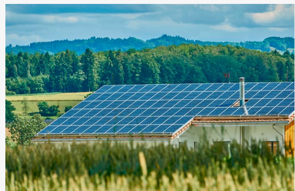
Photo : installation de SolarX.
