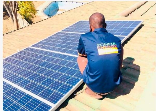
Photo : Zonful ; installation de panneaux solaires.
